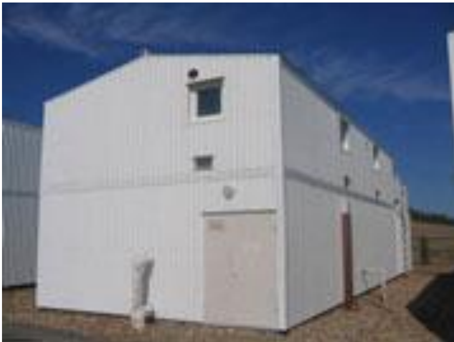
Рисунок 20 Внешний вид очистных сооружений «Биоресурс»
